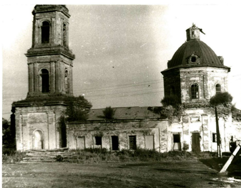
Рис. 5. Фотография северного фасада.
